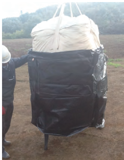
写真3. 通常フレコンを丸ごと詰め替え作業専用耐候性フレコンへ詰込
