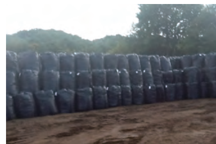
写真5. 詰め替え作業専用耐候性フレコンへ詰込作業終了
